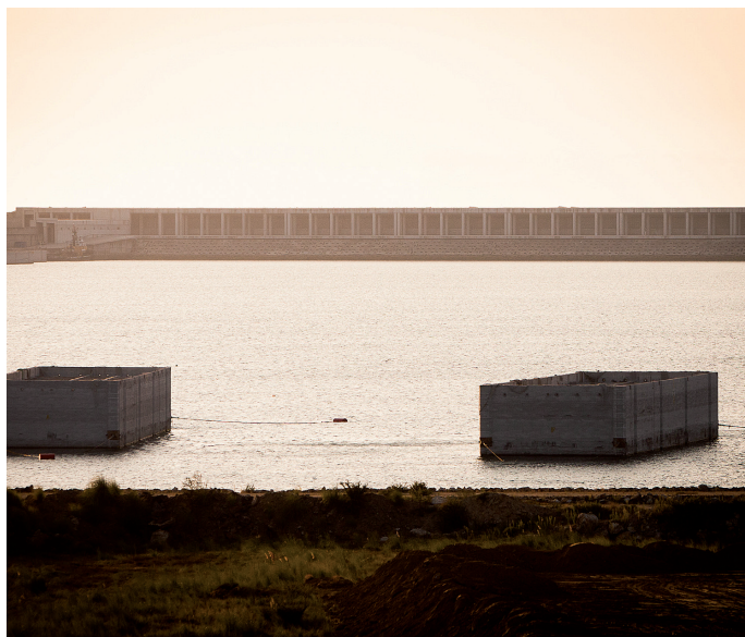
Ampliación puerto de Aberdeen. Fabricación de cajones de hormigón. La Coruña. Galicia.
