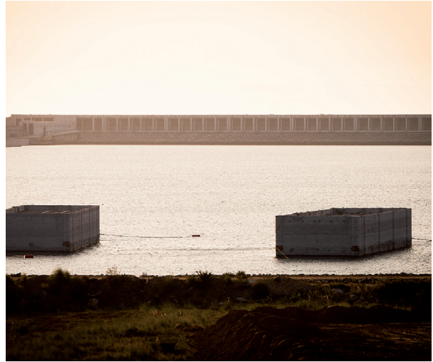
Ampliación puerto de Aberdeen. Fabricación de cajones de hormigón. La Coruña. Galicia.
