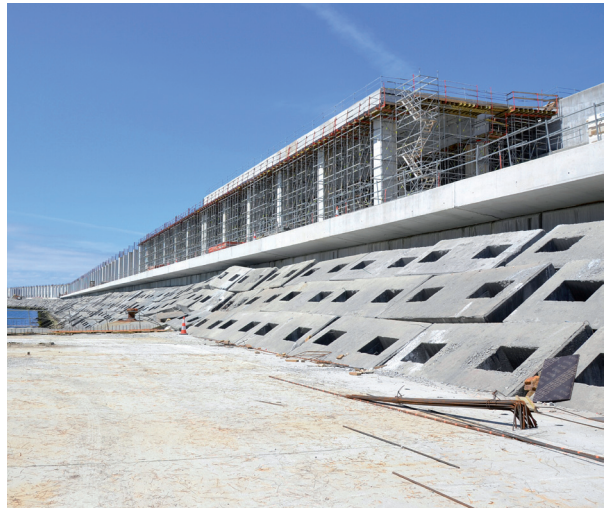
Galería de protección puerto exterior de Punta Langosteira. La Coruña. Galicia.
